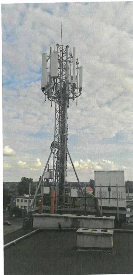
Zdjęcie 1 Badany obiekt
