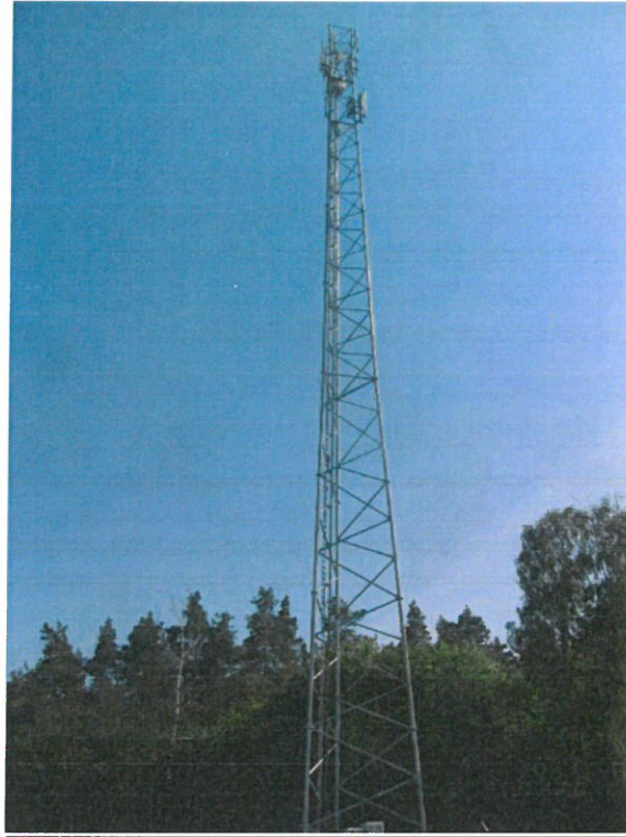
Zał. nr 1: Widok ogólny instalacji radiokomunikacyjnej.
